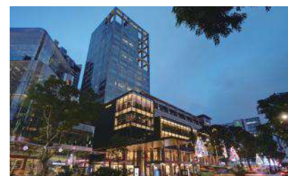
■ Courts Asia オーチャードホール
