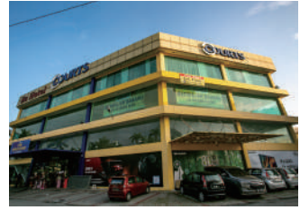
■ マレーシア COURTS IPOH
